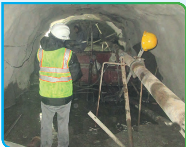
Alimac Pocket Concreting कार्य हुँदै
